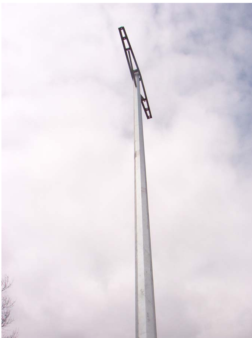
Cevasti stub od čelika u ulozi nosećeg uporišta za jednosistemski 10 kV nadzemni vod pripremljen za dalju montažu (izolatora i provodnika)
